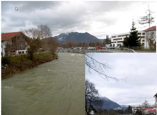
Hochwasserschutzmauer entlang der Konstanzer Aach im Bauabschnitt 1
