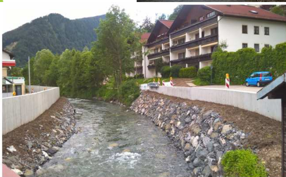
Hochwasserschutzmauer entlang der Konstanzer Aach im Bauabschnitt 3
